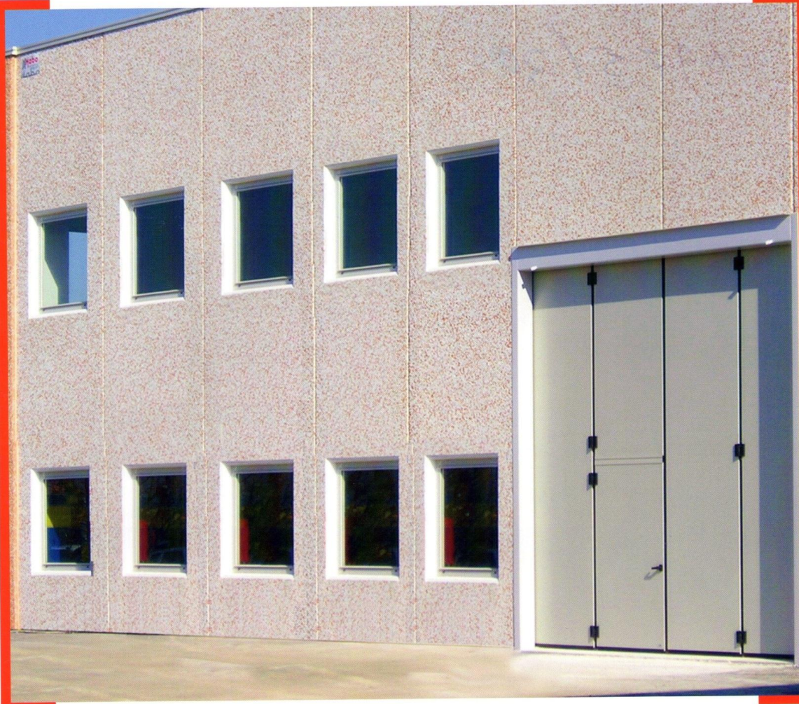
Immagine in alto: finestre incassate su pannelli prefabbricati
