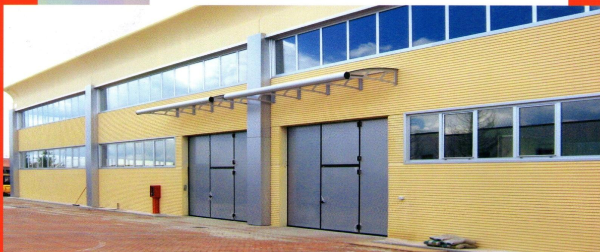
Immagini in alto: finestre a nastro montate su pannelli prefabbricati
